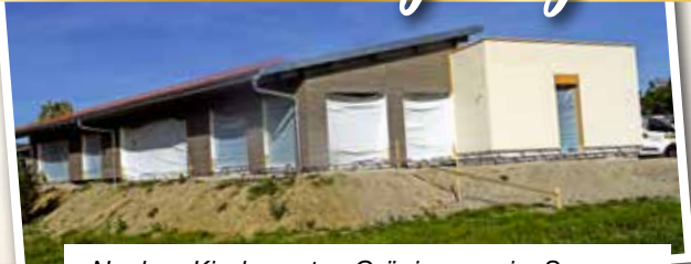
Neubau Kindergarten Gröningen – im Sommer wurde ein schönes Richtfest gefeiert
