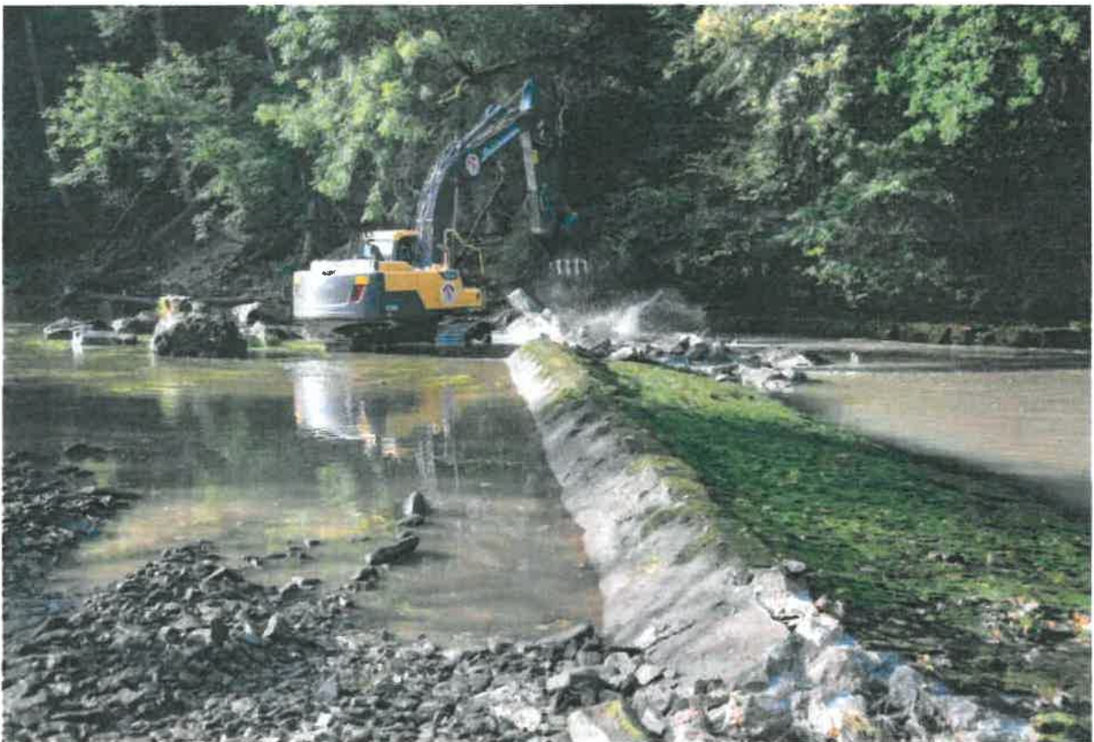
Abbildung 4: Beginn der Umbauarbeiten am Beispiel Gaismühle, Foto Landesbetrieb Gewässer
