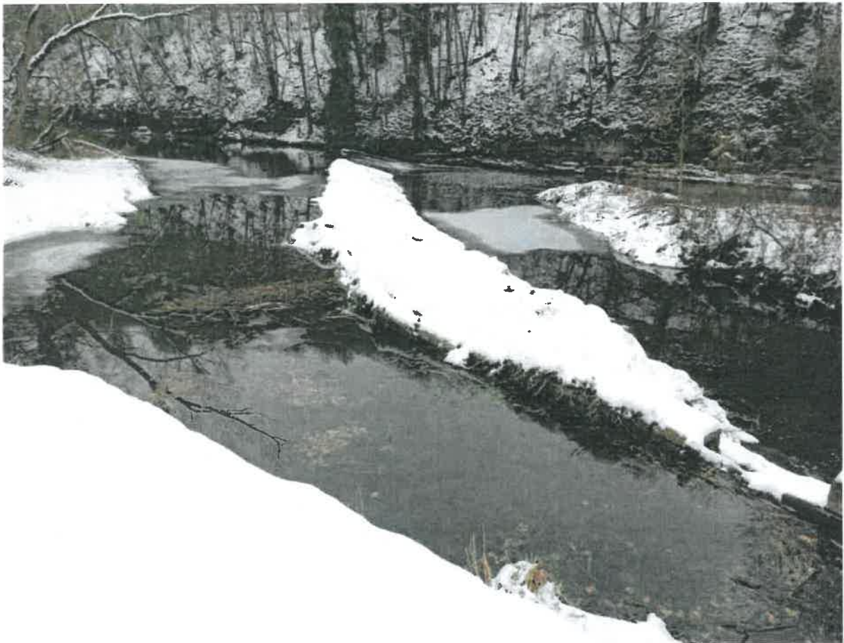
Abbildung 1: Blick vom rechten Ufer auf das Streichwehr, im Vordergrund rechts der Zulaufbereich zum ehemaligem Turbinenhaus mit Leerschuss. Foto Landratsamt Ostalbkreis
