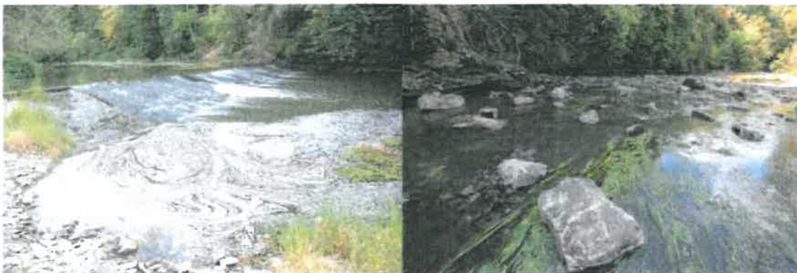
Abb.: Beispiel - Wehr der Gaismühle vor und nach dem Rückbau 2016 (Quelle: RP Stuttgart, Landesbetrieb Gewässer)
