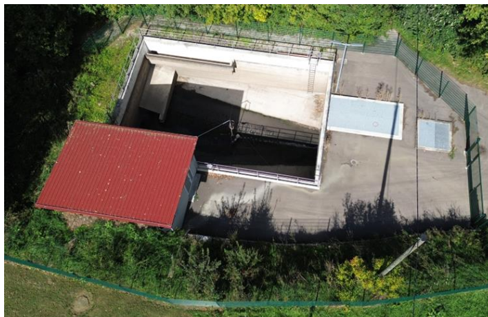
Ansicht der Pumpstation Gröningen
